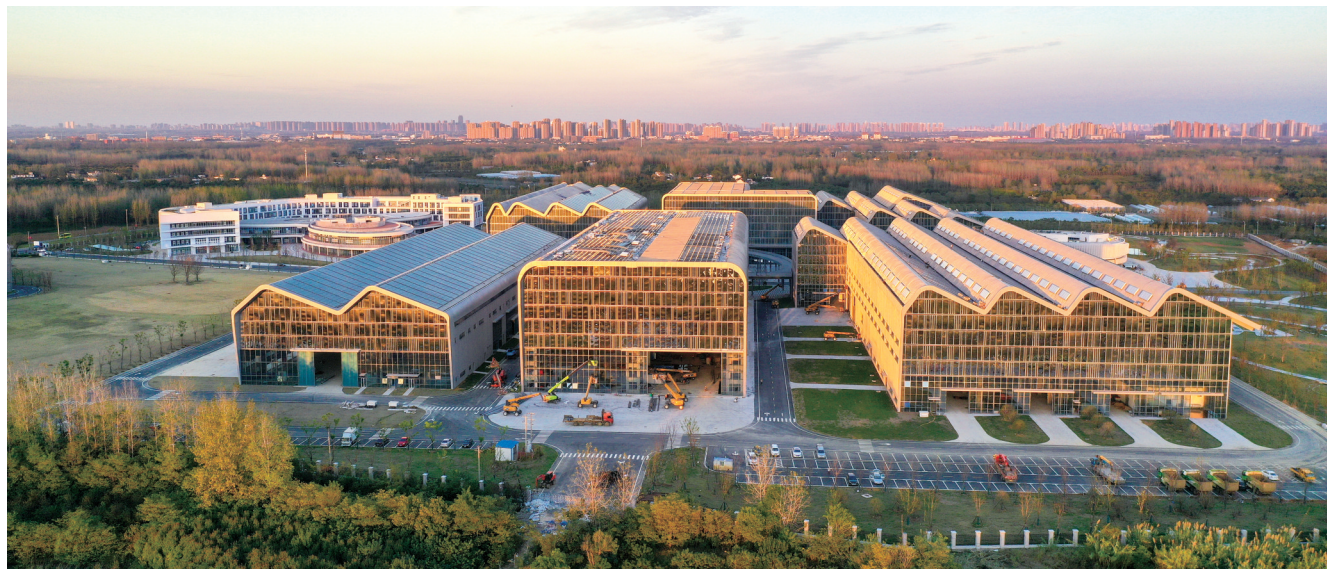
位于合肥未来大科学城的聚变堆主机关键系统综合研究设施。
