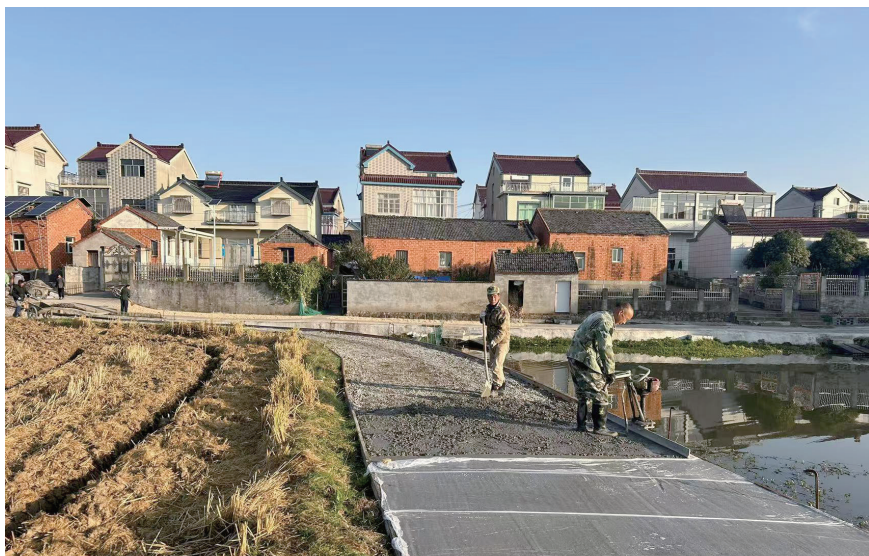
小水东村机耕路硬化施工现场。
